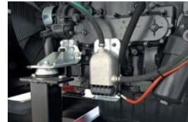
Kühlmittelheizung Water heater
